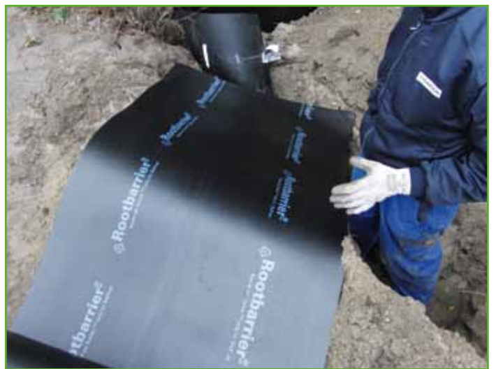
Das Einsetzen von RootBarrier® 420 bei einem Garten in Rotterdam.
