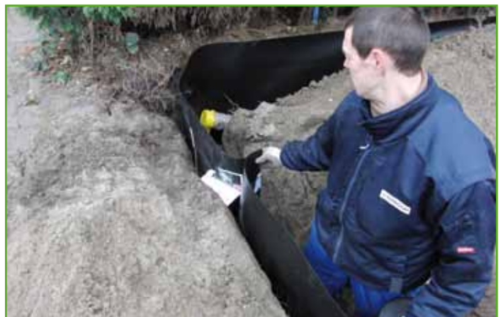
Um das Ende von RootBarrier® 420 geben wir die Click Connection.
